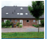
Schlüsselfertiger Bau von Mehrfamilienhäusern
