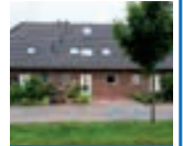
Schlüsselfertiger Bau von Mehrfamilienhäusern
