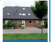
Schlüsselfertiger Bau von Mehrfamilienhäusern
